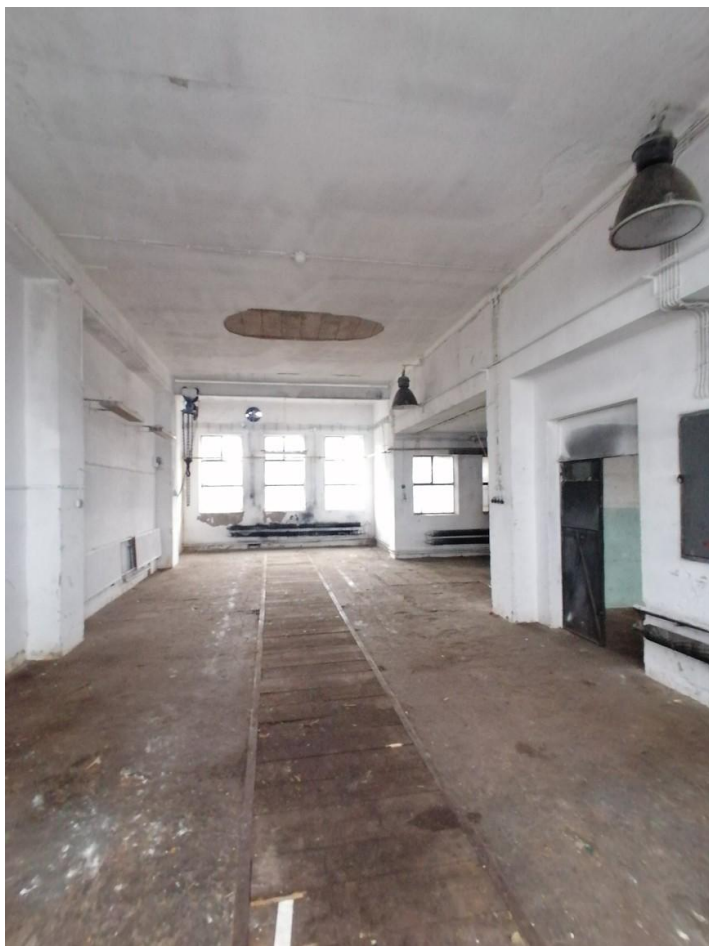
interiér dílen a garáží
